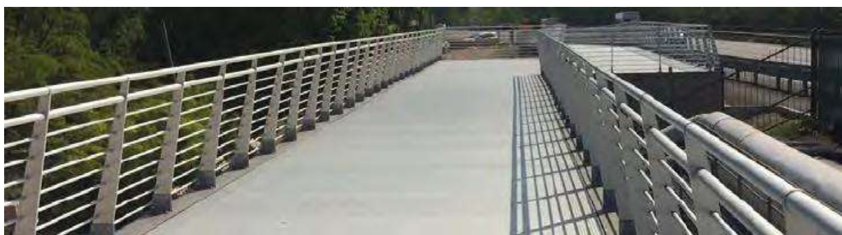
Figura 03.a: Esempio realizzativo della struttura del parapetto in progetto (che sarà realizzata in acciaio zincato a caldo preverniciato di colore marrone effetto corten)
